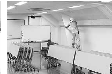
4階クロスはがし作業
