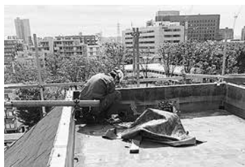
屋上防水作業
