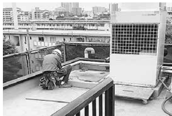
室外機取り外し作業
