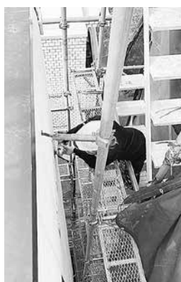
看板取り外し作業
