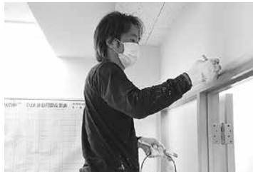
内部塗装作業
