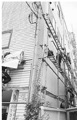
足場の組立て等作業
