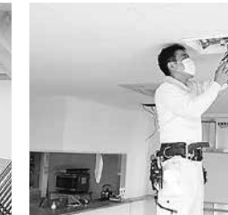
3階電気交換作業
