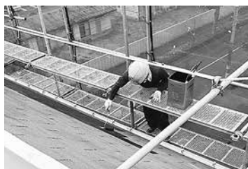
屋根防水作業
